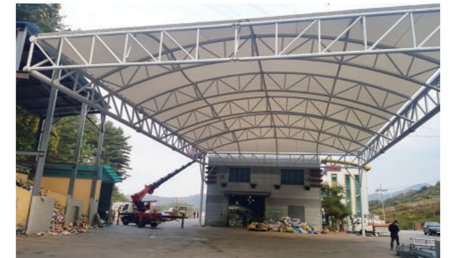
가평 재활용선별장 반입장 지붕
